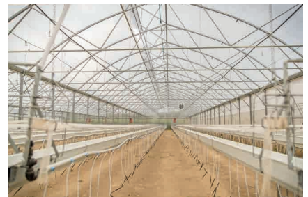
Montage und Baubegleitung
